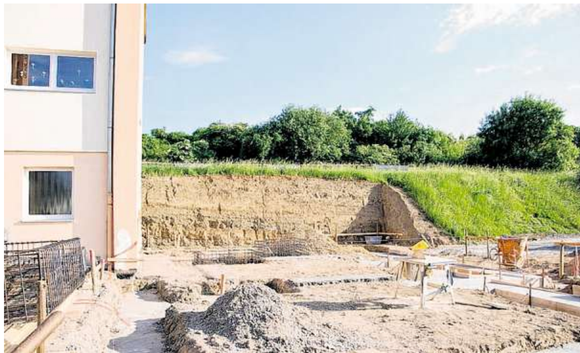
Baustelle Schule: Begonnen haben Arbeiten für den Anbau an der Schule in Mainstockheim. Darin sollen ab kommenden Schuljahr die Kinder für die Mittagsbetreuung untergebracht werden. FOTO: RALF WEISKOPF
